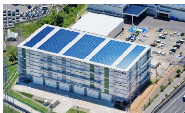
リエネLOGI'Q枚方 太陽光発電所
