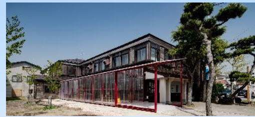
男鹿駅前の事務所跡 海上輸送で栄えた船川港 駅前広場に隣接 港町の歴史を感じる建物
