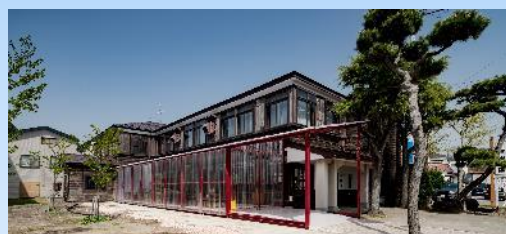
男鹿駅前の事務所跡 海上輸送で栄えた船川港 駅前広場に隣接 港町の歴史を感じる建物
