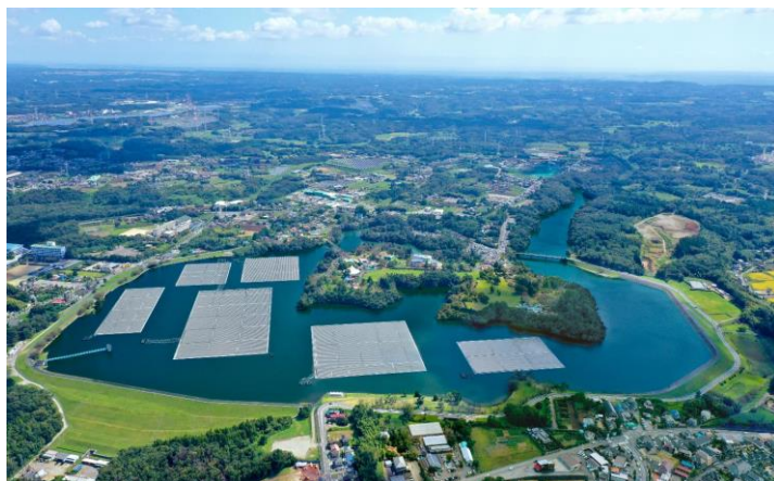
千葉・山倉水上メガソーラー発電所 (13.7MW)
