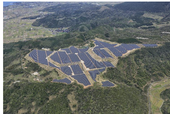
鳥取・米子太陽光発電所 (29.2MW)
