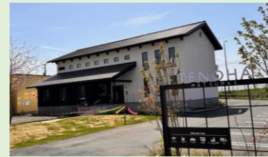
〈松前町との調和を重視した外装〉
