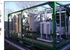
メタン発酵バイオガス発電設備
