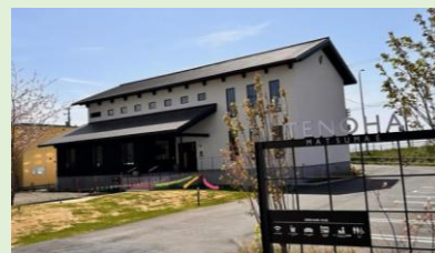
〈松前町との調和を重視した外装〉
